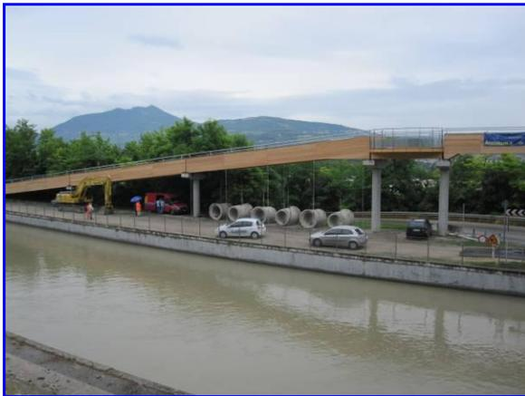
*Foto 1: Panoramica della prova di carico sulla 3<sup>a</sup> campata da nord*
