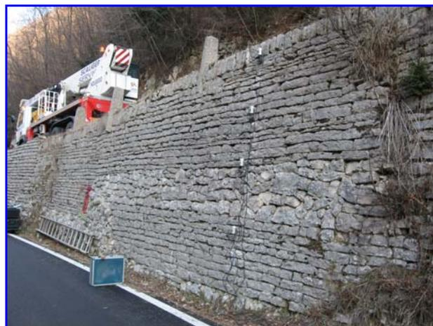
*Foto 2: Panoramica di quattro inclinometri posizionati su un muro di sostegno*
