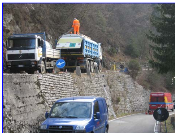
Foto 8: Fase di riempimento della cisterna
