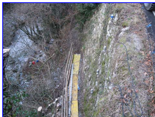
Foto 12: Panoramica del muro oggetto di prova
