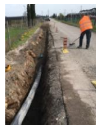
Lavori in corso per le fognature
